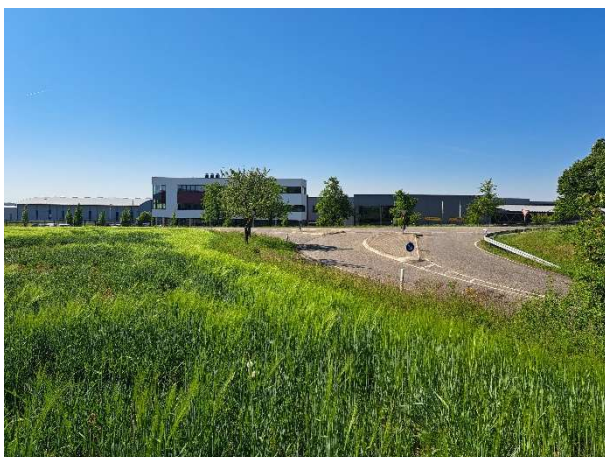
Abbiegespur von der Kreisstraße Alle Bilder Klärle GmbH 2025
