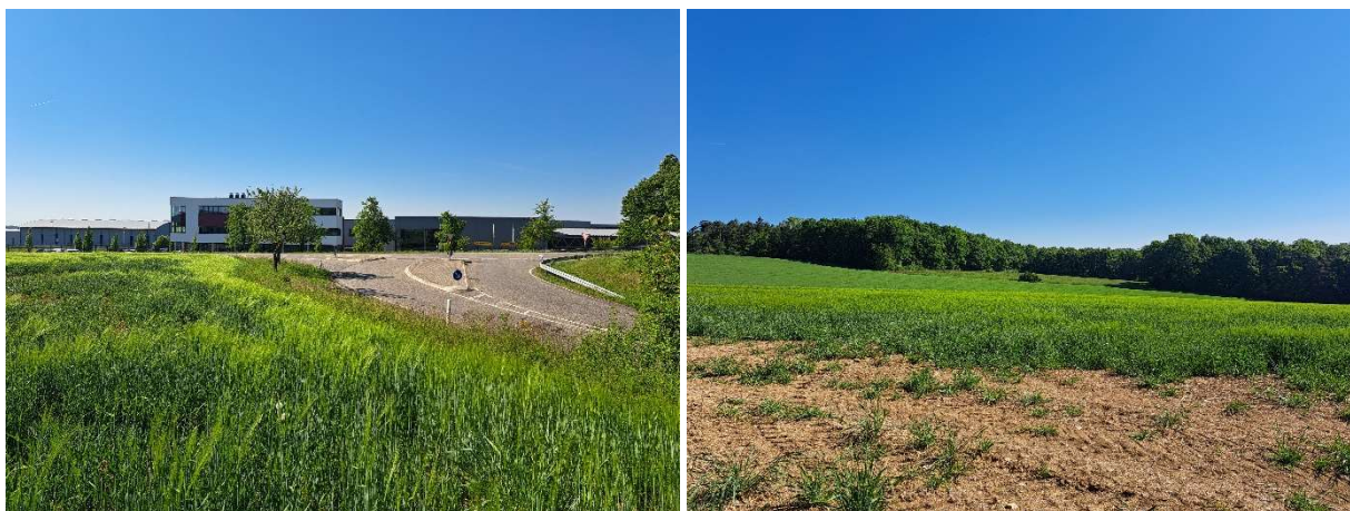
9 Abbiegespur von der Kreisstraße Alle Bilder Klärle GmbH 2025
